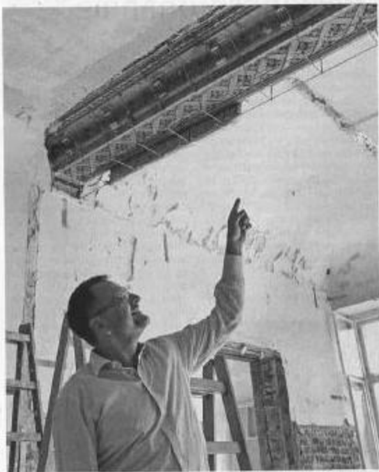
Ulrich Kasper zeigt den freigelegten Holzstuck.
